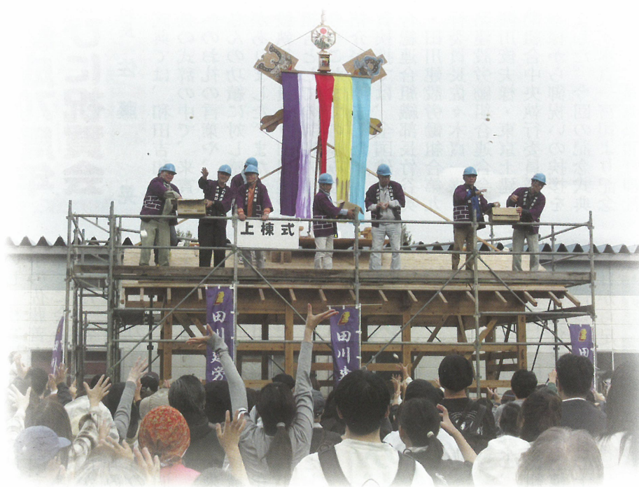
▲令和7年『庄内森とみどりのフェスティバル』上棟式の様子
